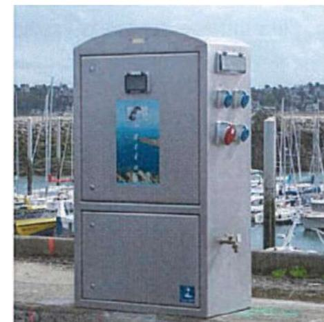
L'utilisation des bornes énergie et de la station de lavage seront gérées à partir d'une borne de gestion de paiement CB qui permettent aux usagers d'acheter des services en toute autonomie. Après la sélection d'un emplacement, l'utilisateur pourra enclencher la distribution d'eau et d'électricité pour une durée déterminée.
