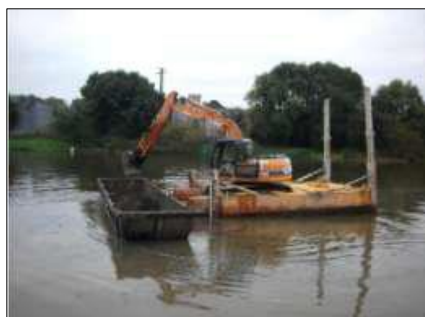
Dragage par pelle mécanique Bassin de décantation de la Mole (Gujan-Mestras)
